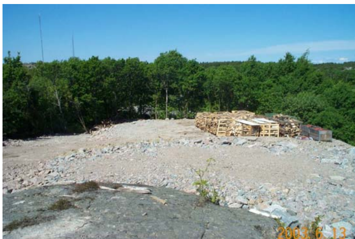
Område där markutfyllnad gjorts.
