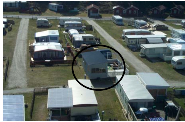
Samma villavagn med ny fasad och tak.
